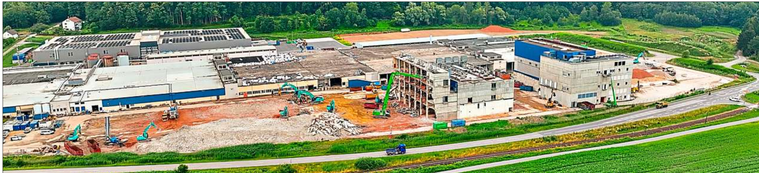
Die Abbrucharbeiten auf dem TWD-Gelände Anfang Juli. Von den hohen Gebäuden an der Staatsstraße steht mittlerweile nur noch das rechte. Auf den niedrigeren Hallen dahinter wird in Handarbeit die mit Asbest belastete Dachpappe abgenommen und in weißen Säcken gelagert. Links hinten die Halle, die Karl für den Spülenhersteller Schock umgebaut hat.
